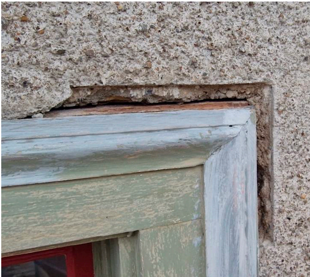
Detailansicht der Sanierung der Fensteranschlüsse, um Wasserschäden zu verhindern.
