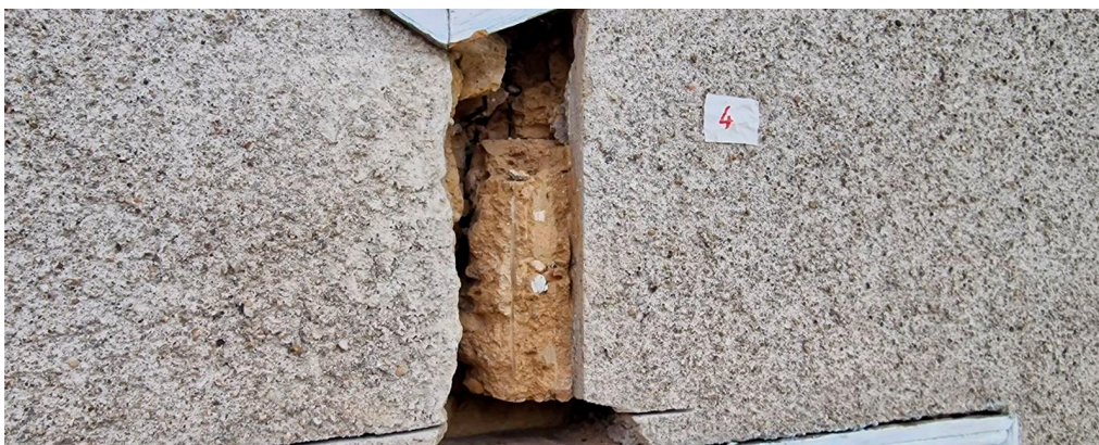
Geöffnete und gereinigte Schadstelle im Verputz: Für kurze Zeit war die Stamflehm-mauer gut ersichtlich.
