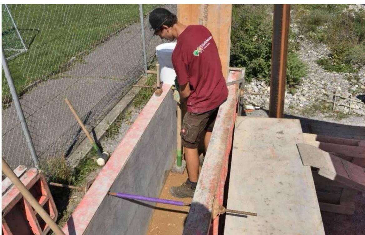
Schicht um Schicht einbauen und von Hand stampfen
